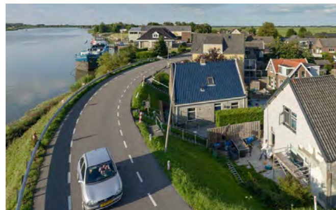
Een smal dijkprofiel aan de IJssel met bestaande bebouwing dicht op de dijk
