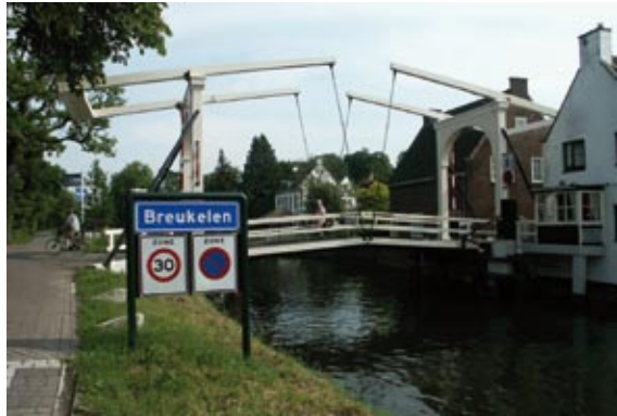
● Vechtbrug in Breukelen
